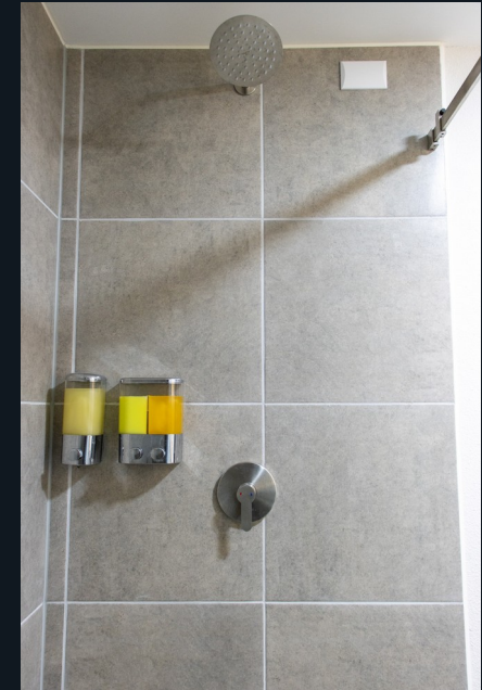
Detalle de ducha y revestimiento
