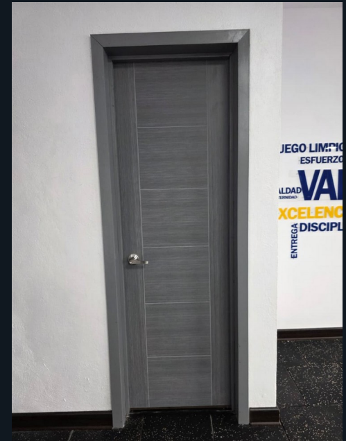
Puerta junto al acceso interior
