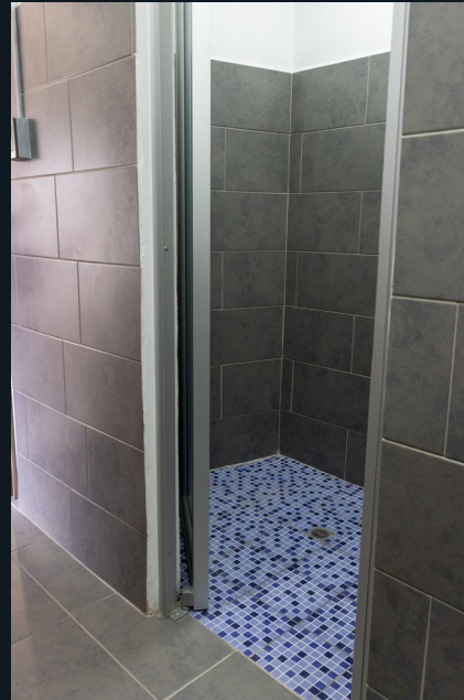
Piso y revestimientos del área de ducha
